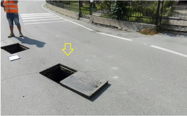
Foto 14195. Pozzetto di sfioro.
