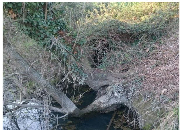
Foto 15001. Scarico della condotta nella conca.
