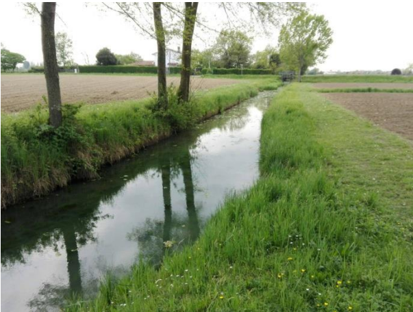
Foto 08199. Canale Pentia Musestre a valle del manufatto di regolazione.
