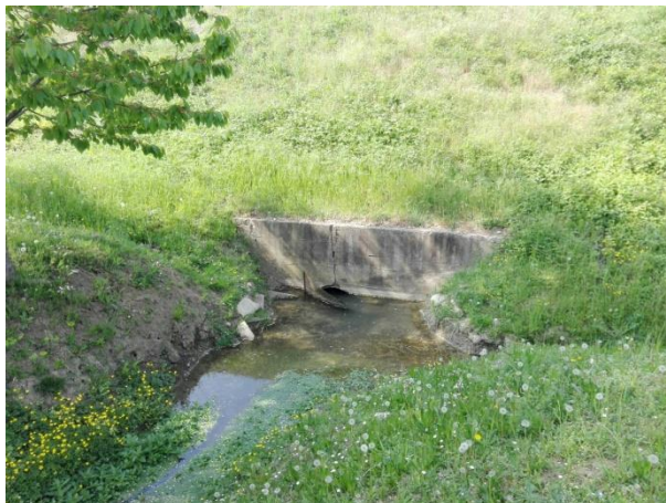
Foto 07241. Attraversamento rilevato del cavalcavia S.R.53.
