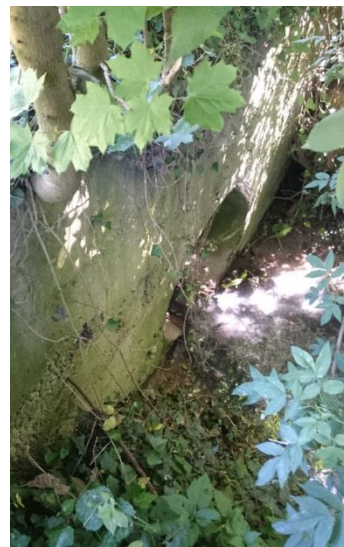
Foto 15052. Scarico attraversamento.
