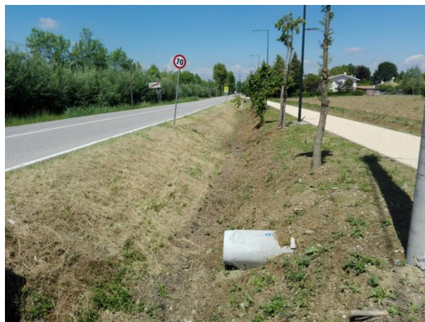
Foto 09102. Fosso lungo via Sant'Elena.
