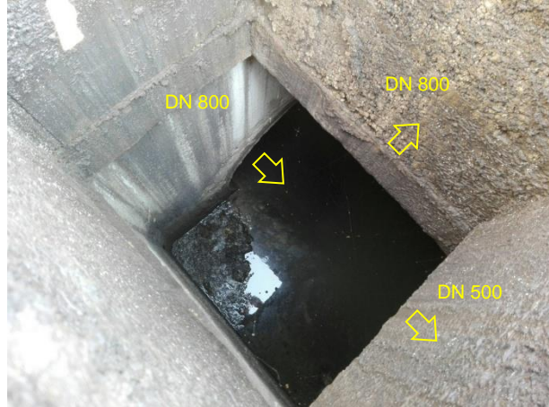
Foto 14196. Pozzetto di sfioro.
