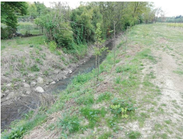
Foto 08137. Canale scolmatore a valle della chiavica.
