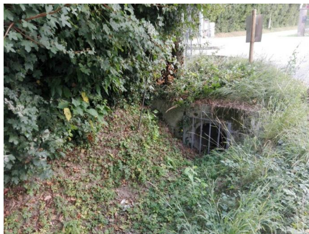
Foto 11009. Immissione delle scoline nella condotta lungo la pista ciclabile.
