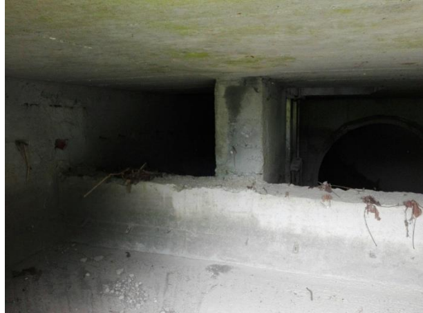
Foto 08021. Setto del manufatto regolatore.
