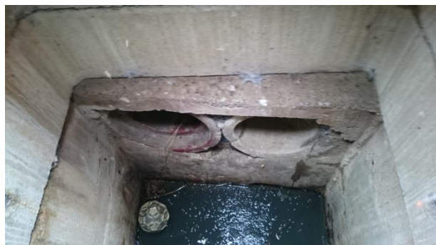
Foto 16010. Condotte DN 400 in basso (sommerse) e condotte DN 400 del troppo pieno in alto.
