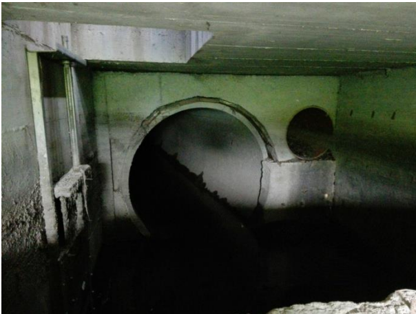
Foto 08023. Manufatto regolatore. Condotta proveniente dall'area commerciale, condotta proveniente da strada laterale e paratoia di regolazione.
