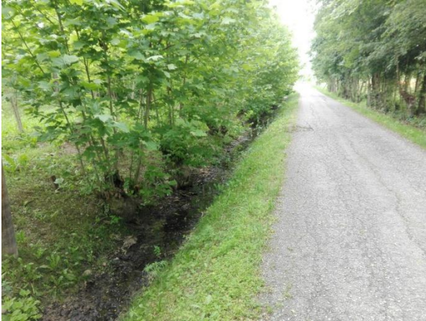
Foto 10000. Capofosso via Surexit a sud della S.R.89.
