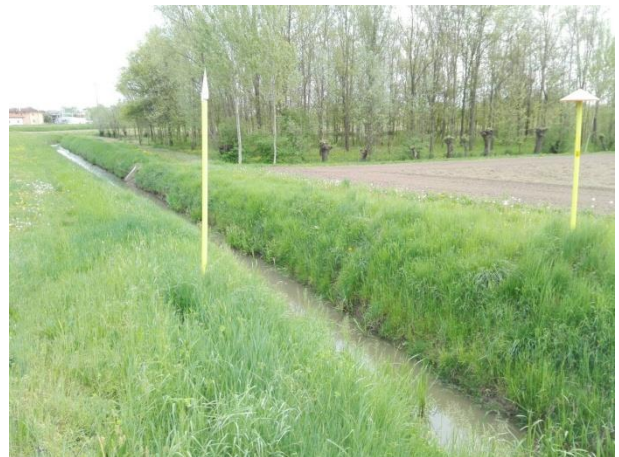
Foto 06192. Fosso Montiron a valle dell'attraversamento della S.R.89.
