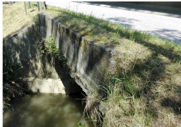
Foto 09099. Canale Pentia Sile. Attraversamento di via Sant'Elena a valle.
