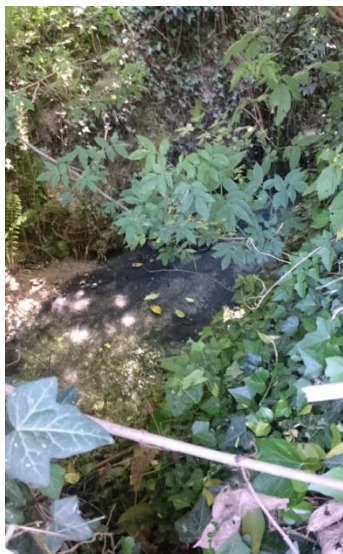
Foto 15051. Capofosso a valle dell'attraversamento.
