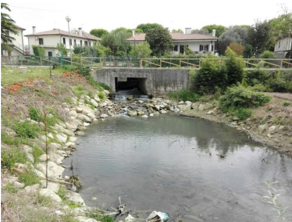
Foto 08136. Chiavica di derivazione lato canale scolmatore.
