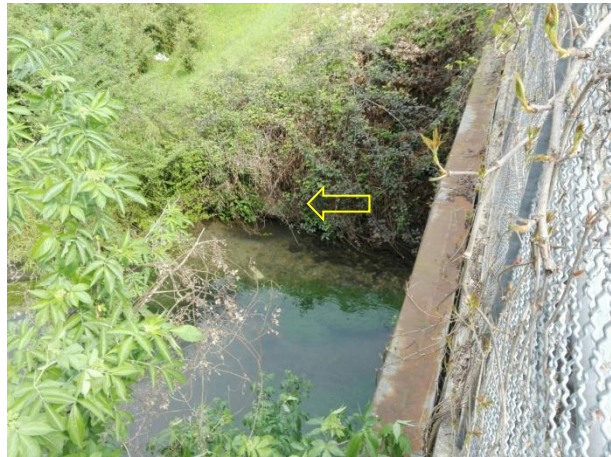
Foto 04138. Scarico nel Melma all'altezza del ponte sulla SR.53.
