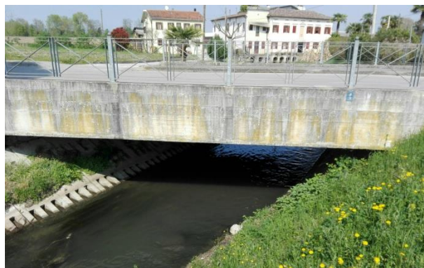
Foto 05164. Ponte via Ca' Memo sul Nerbon.
