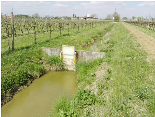
Foto 06145. Manufatti di regolazione privati lungo il capofosso.
