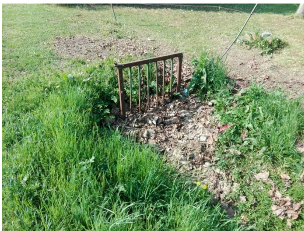
Foto 05186. Condotta interrta in via Molino.
