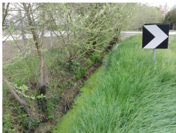
Foto 05114. Ristagno in via Pantiera lato est verso sudd.
