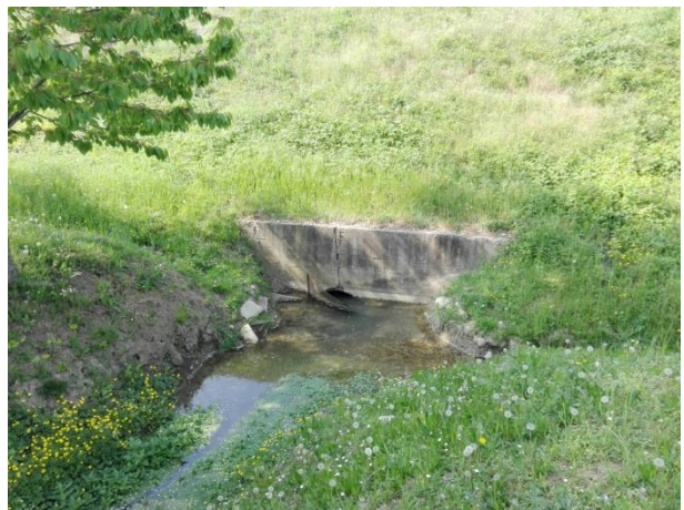
Foto 07241. Attraversamento rilevato cavalcavia S.R.53.
