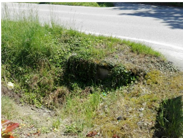
Foto 09116. Attraversamento di via bassa Trevigiana all'altezza dell'incrocio con via Canton.
