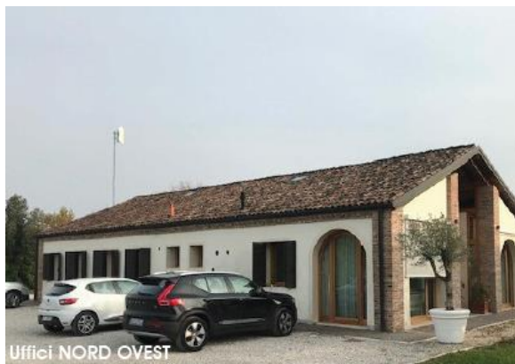
Edificio 1 – Vista da nord ovest
