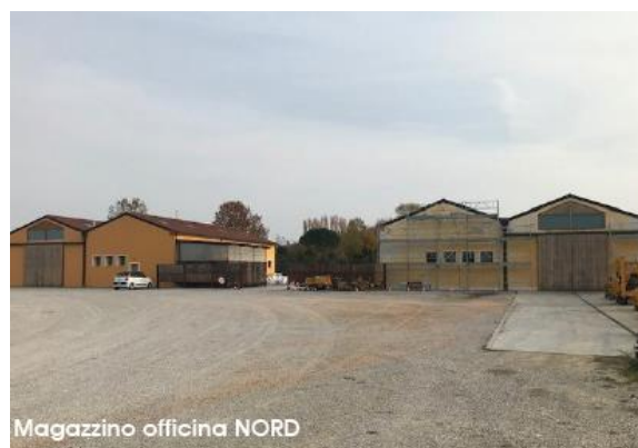
Edificio 2 – Magazzino officina NORD
