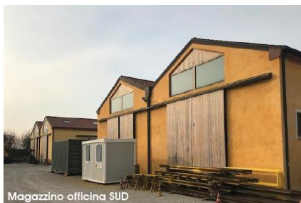
Edificio 2 – Magazzino officina SUD
