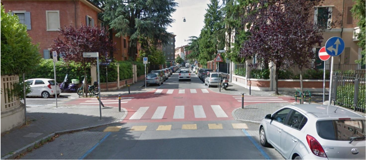
Fig. 4.2 – Esempio di sistemazione di incrocio rialzato
