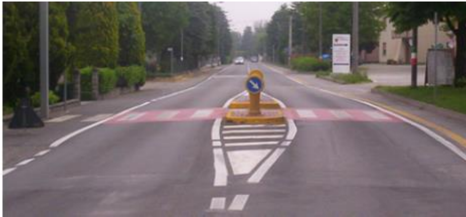
Fig. 4.7 – Esempio di isola spartitraffico
